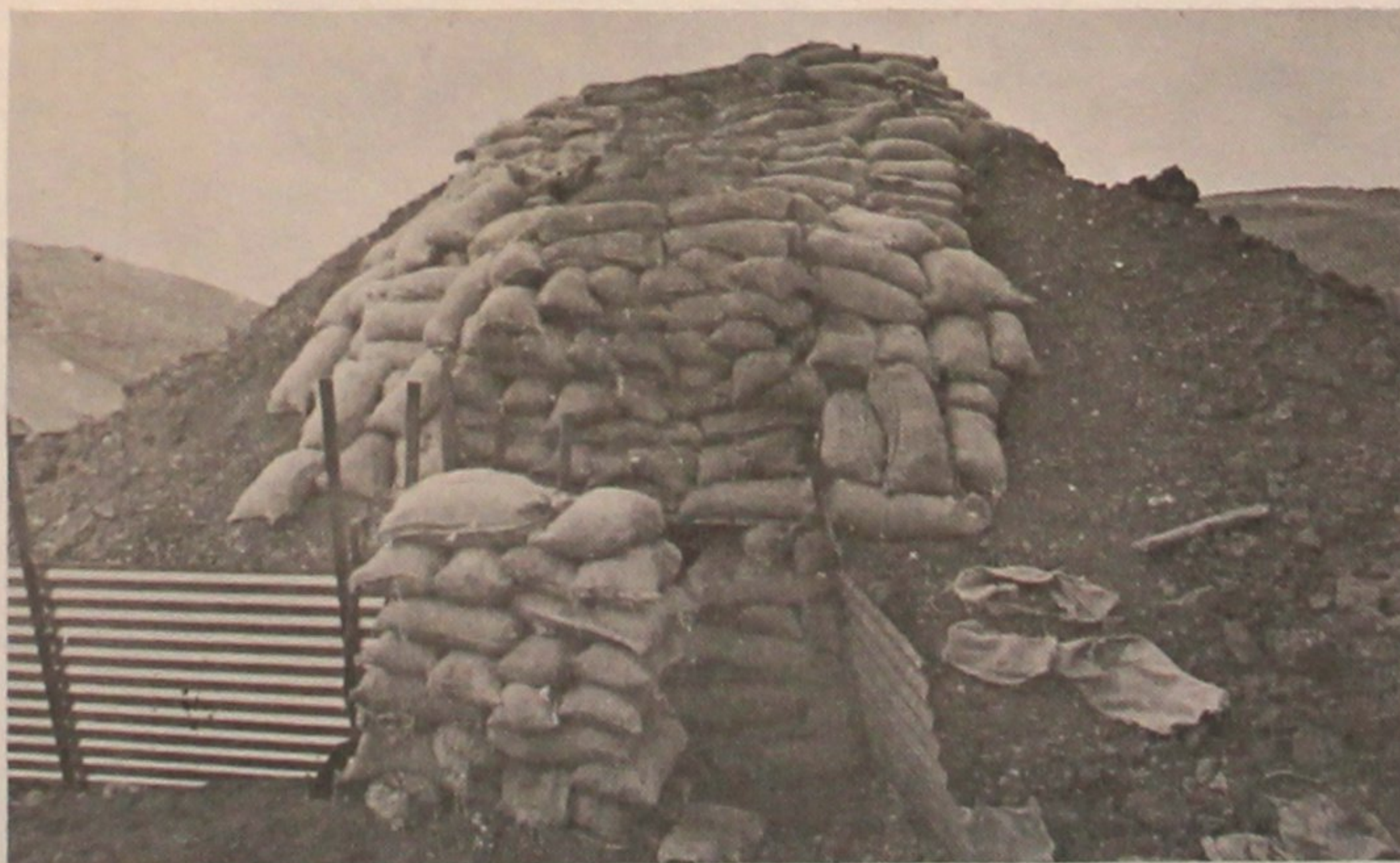
Lt Esten Kolstad t.v. Dekningsgrommet på 4.5. A er solide saker. 600 sandsekker i taket. Høyden under taket er også upåklagelig. Selvsjef KP A kan stå oppreist.
