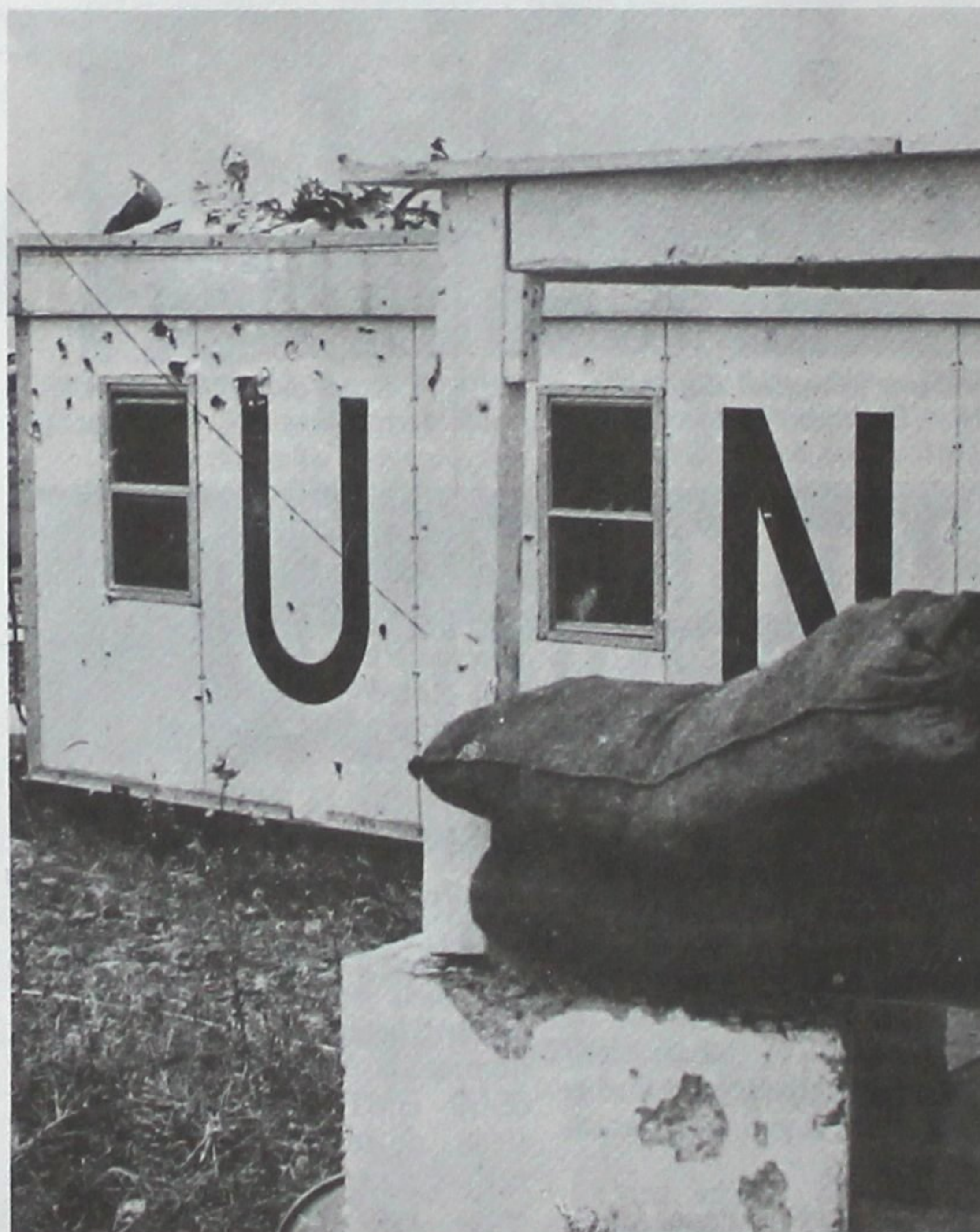
Storparten av prefab-brakkene i Naqoura-leiren hadde skudd-hull. Denne ligger like ved porten til NORAIR og har fått en fulltreffer fra en bombekaster – det er lite å koste reparasjon på.
