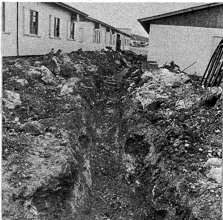
Efter gravingen i NORMEDCOY så sykehusområde ut som en middels norsk anleggsplass.
