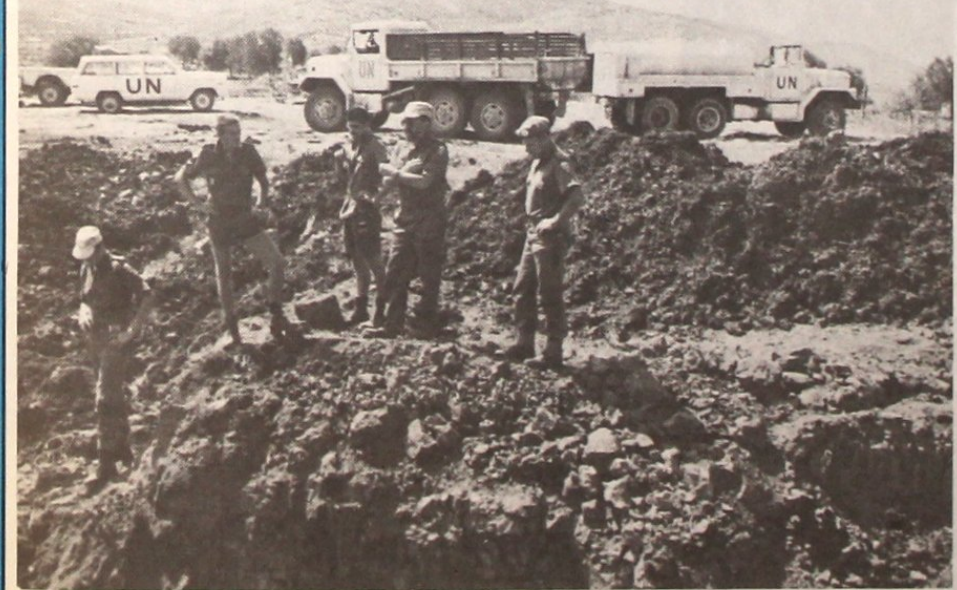
Oberst Ole Rønning og major Knut Aase inspiserer arbeidet med å få tettet lekkasjene på det gamle vannledningsrøret. I dyptet av hullet ser vi tre av dem som sto på sent og tidlig, nemlig löytnant Carlsen, fenrik Barmen, og menig Odland. Flott innsats!
