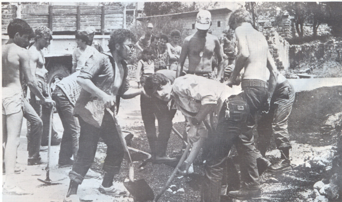
Sivilbefolkningen var meget ivrige etter ä få være med på asfaltarbeidet i Rachaiya.
