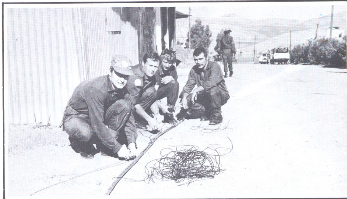
Karene fra Sambandstroppen er klar til å trekke kabela som skal sikre den nye el-forsyningen. Fra v. Arvid Kårevik, Askøy sjefen for Sambandstroppen, lt. Per Solli, Arnvid Rydfjord fra Andalsnes og Arne Hammer fra Frøya.
