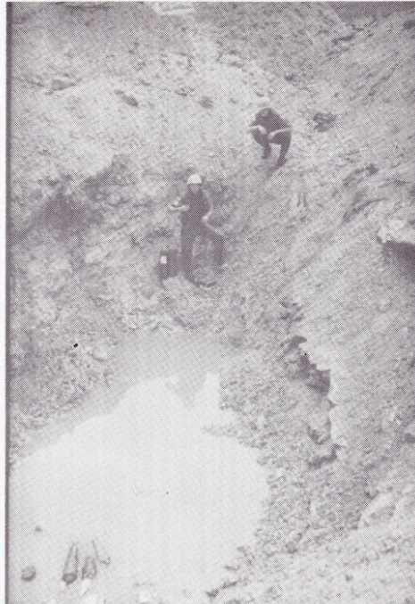
Seks kilo TNT er lagt ned for å sette av granatene. Fenrik Stromsheim (nede i Gropen) og fenrik Halås kan forberede selve sprengningen.
