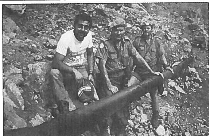
Tolken George fra Kaukaba, som også er med i vannverksstyret, er her fotografert sammen med ingeniöroffiser Pettersen og hans assistent, fenrik Bergsås. Ras har revet bort steinkisten over vannledningen, som dermed henger i løse luften.
