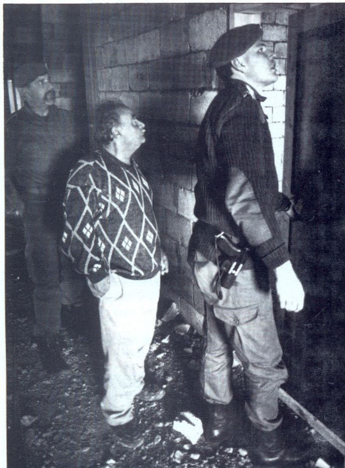
Det er ikke få detaljer som skal kontrolleres. Her ser major Rune Røen (til høyre) på ei dør, mens hovedkontraktøren og major Johs. Irgens også følger med. (Foto: Tom Lysø)
