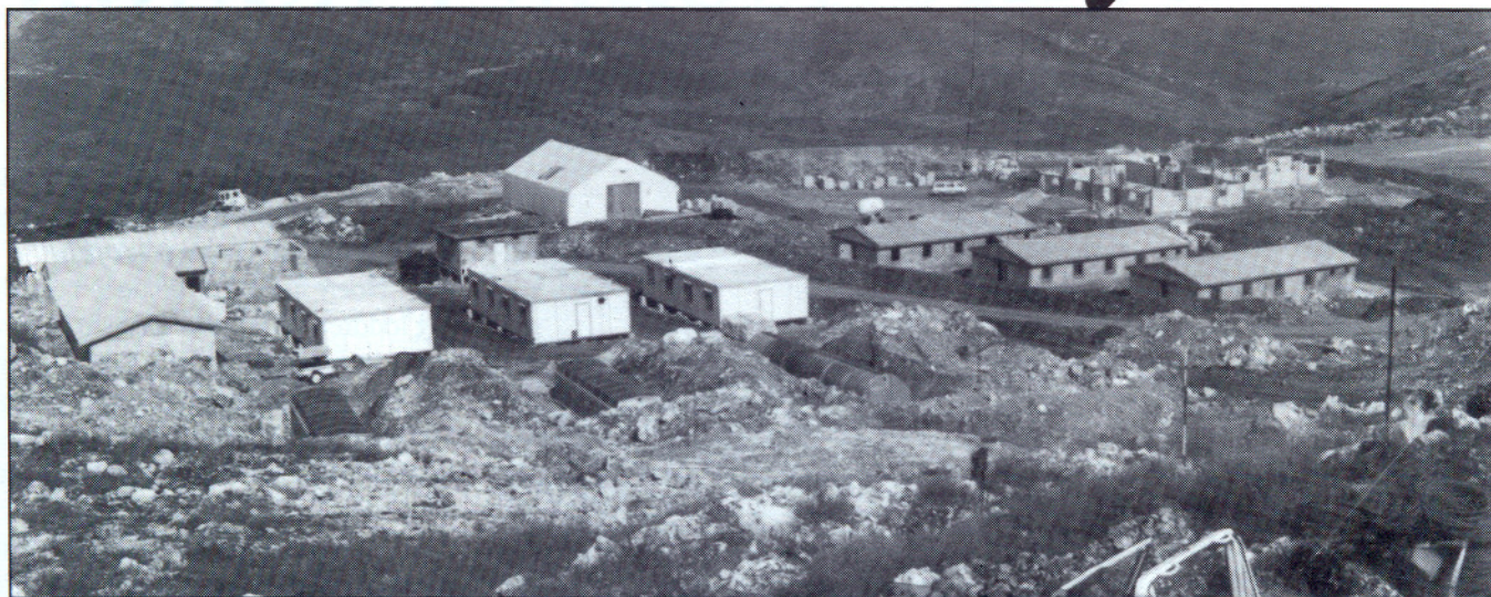
Panoramautsikt over byggeprosjektet. (Foto: Richard Kongsteien)
