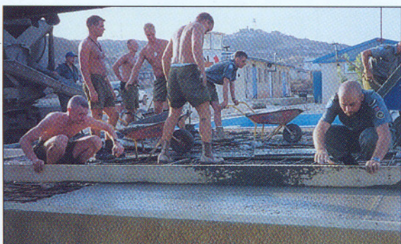
Mye arbeid med bassenget...
